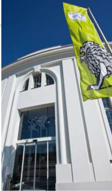
Die neue Kirchdorfer-Verwaltungszentrale in Wöllersdorf.
