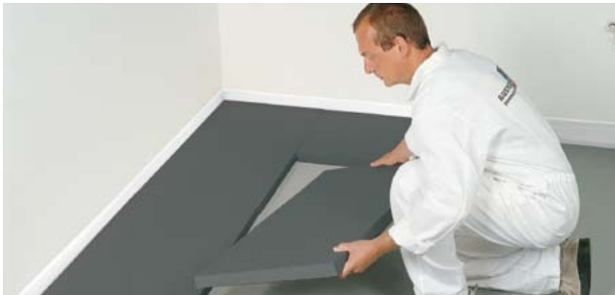
4 in 1: Trittschalldämmplatten bieten vier Vorteile in einem: Trittschallschutz, verbesserten Luftschallschutz, ausgezeichnete Wärmedämmung und geringe Setzung.
