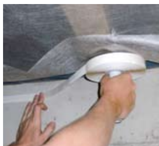
Die Dichtmassenraupe Airstop Dimaroll von IsoCell wird wie ein Klebeband verarbeitet.
