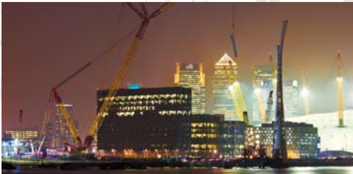
Der LR 11350 stellt bei Nacht den mächtigsten Pylon der Seilbahnanlage an der Themse fertig.
