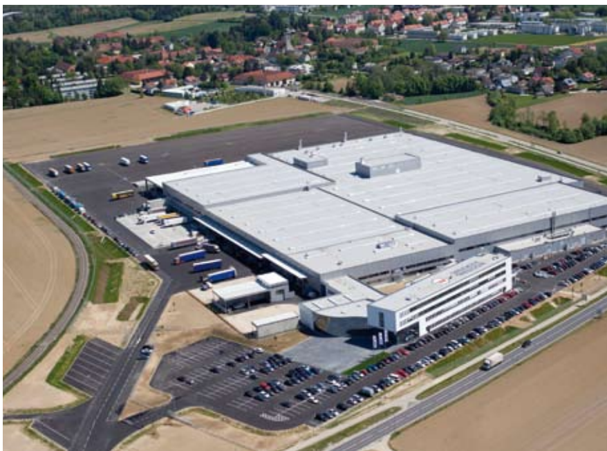
Das neue Wacker Neuson-Werk in Hörsching, von Strabag in nur elf Monaten errichtet
