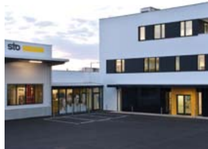
Das neue Sto-Verkaufszentrum in Wien wurde als Passivhaus errichtet.
