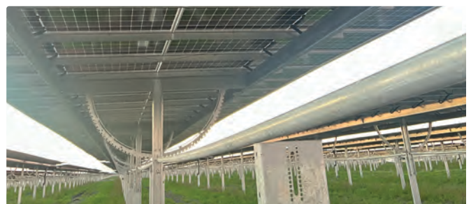
Fotos: David Bohmann, Burgenland Energie AG, Siemens
