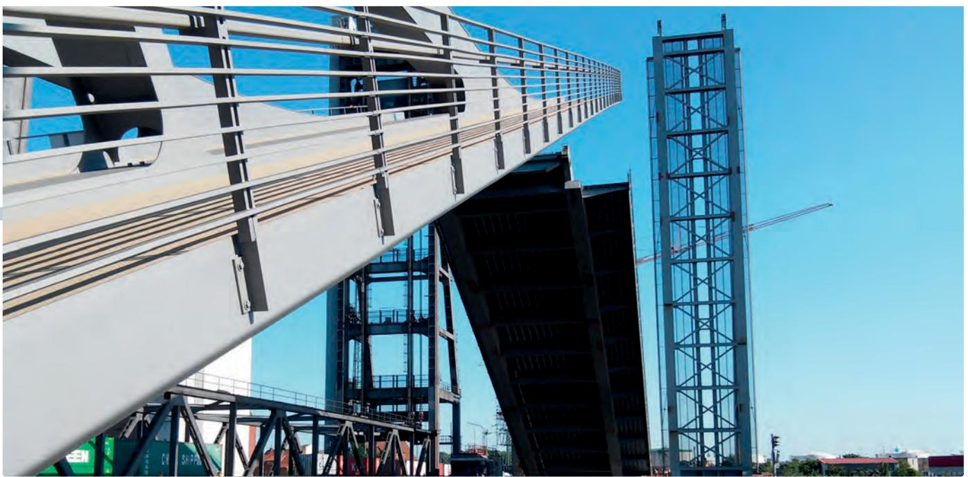
↑ Die Rethebrücke, eine zweiflügelige Klappbrücke, ermöglicht einen raschen Schiffs- und Straßenverkehr im und über dem Rethekanal.
