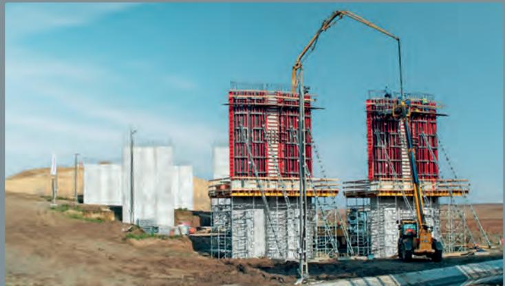
Im Süden Ungarns errichtete die Strabag Építő Kft mit Hilfe von Meva-Lösungen eine Talbrücke der Autobahn M6. Das komplexe Design der Pfeilerpaare mit variabel gekrümmten Oberflächen, senkrechten Einbuchtungen und ansprechendem Fugen- und Ankerbild erschwerte die Schalungsplanung. Die Schalung wurde an den Einbuchtungen entsprechend aufgedoppelt und die Rundschalung Radius, die Säulenschalung Circo und die Wandschalung Mammuth 350 clever mit Sonderelementen kombiniert.
