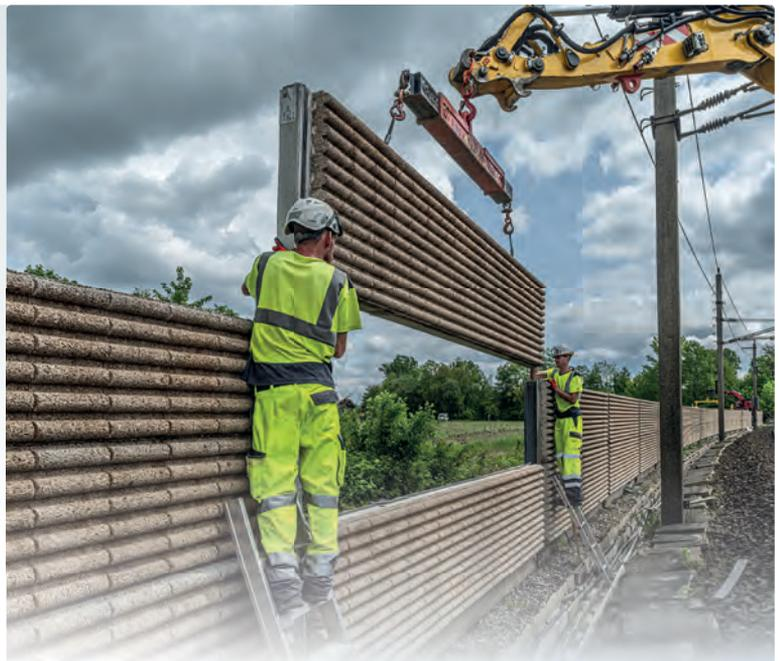
↑ Installation der Teststrecke der neuen Schallschutzwand, deren Tragschicht einen 30-prozentigen Recyclingbetonanteil aufweist.
