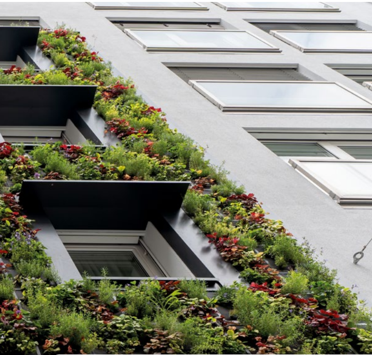
Immer mehr Unternehmen bieten Fassadenbegrünungen an. Bund, Städte und Länder unterstützen Begrünungsvorhaben (im Bild: LivingPanels, Biribauer-Objekt Seegasse).
