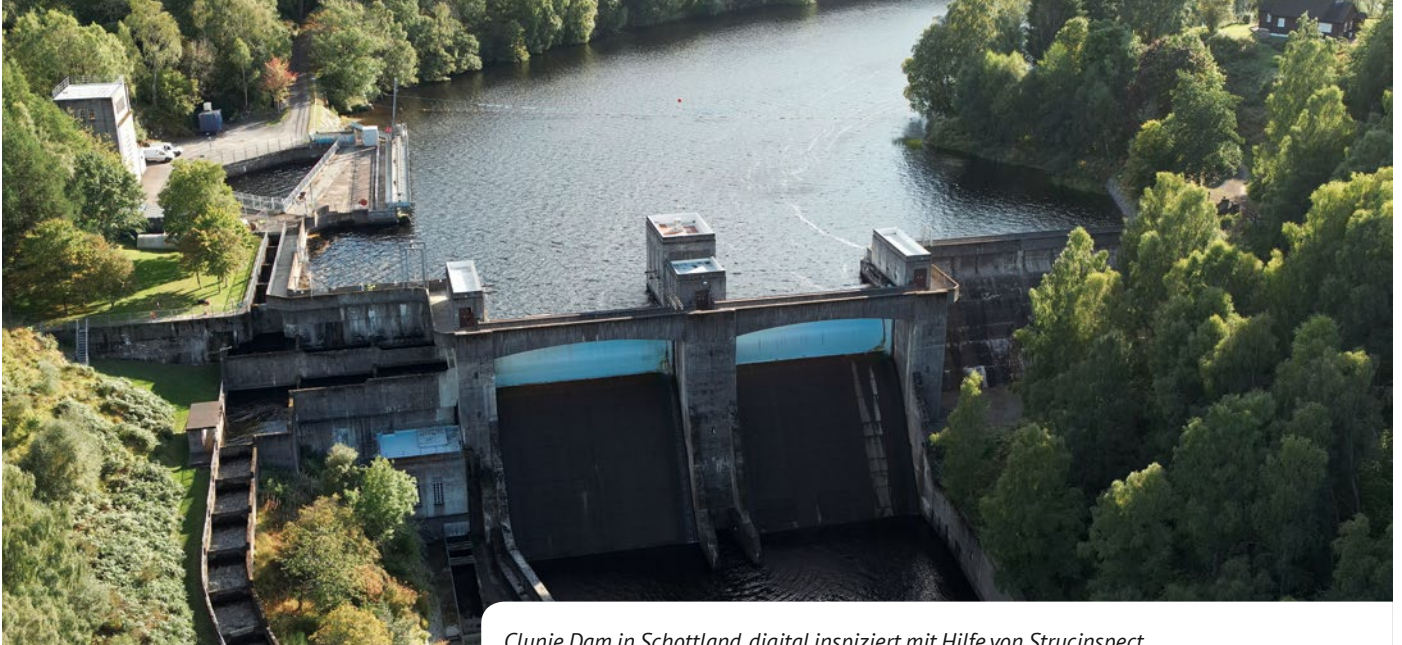
Clunie Dam in Schottland, digital inspiziert mit Hilfe von Strucinspect.
