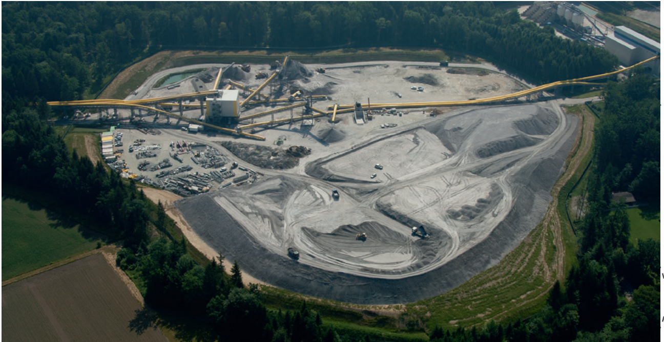
Die Materialaufbereitungsanlage bei der Großbaustelle Koralmtunnel – KAT 2.
