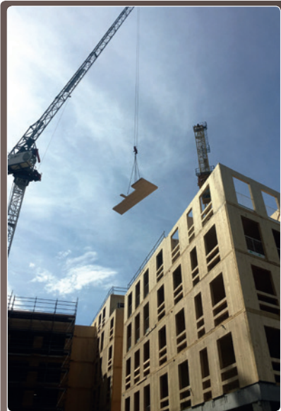
Brettspertholz für den Dalston Lane in London (Bild: binderholz).
