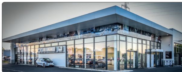
Für BMW Auer hat Leyrer + Graf ein komplett neues Betriebsgebäude errichtet, das nicht nur optisch, sondern auch in Hinblick auf die Energieeffizienz punktet.
