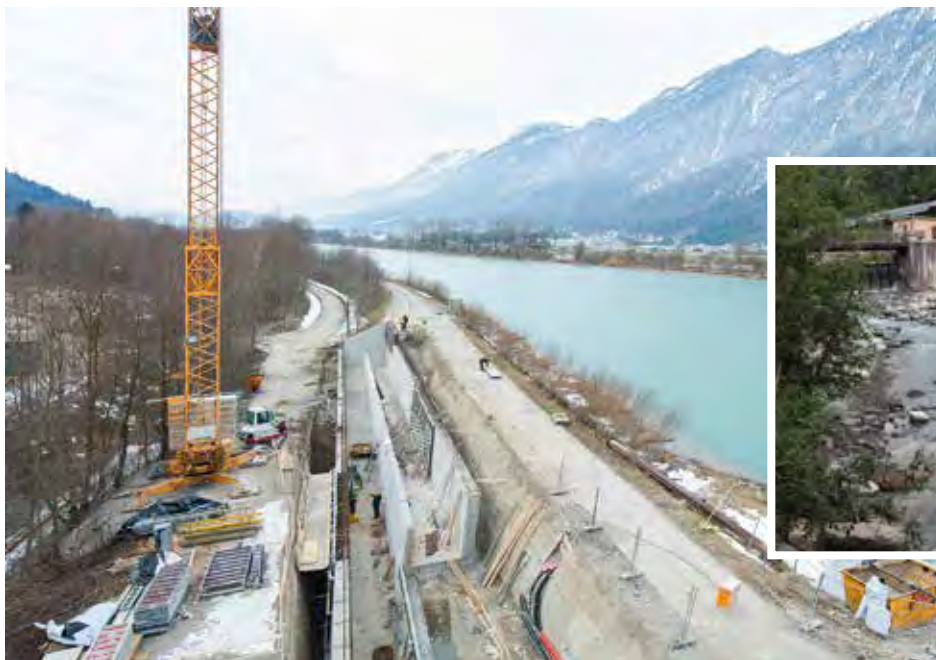
Links: Die Fischwanderhilfe Hirnbach stellt am Kraftwerk Langkampfen die Fischdurchgängigkeit wieder her. Bis Herbst 2015 wird die volle Funktionstüchtigkeit erreicht.
