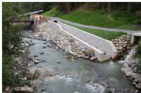
Oben: Fischtreppe an der Pitze: Kleine Wasserbecken ermöglichen Fischen, den Höhenunterschied zwischen Ober- und Unterwasser zu überwinden.
