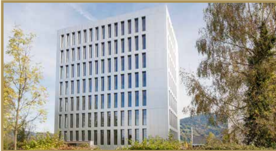
DER LIFECYCLE TOWER in Dornbirn ist ein in Modulbauweise errichteter, ressourcenschonender Holz-Hybrid-Hochbau.
