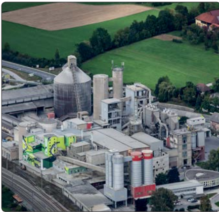
Kirchdorfer Zement setzt auf ein umfangreiches Energiespar-Contracting für die Reduktion von Energiekosten und Emissionen.
